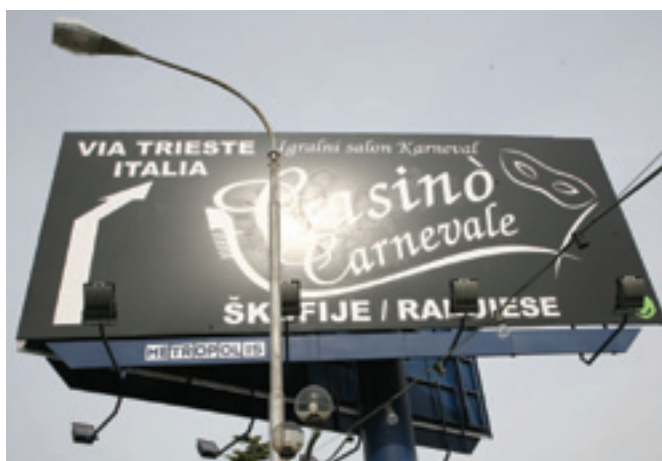
Reklamni pano, ki je nepravilno osvetljen od spodaj navzgor. Slovenska zakonodaja zahteva, da 0% svetlobe seva nad vodoravnico.
